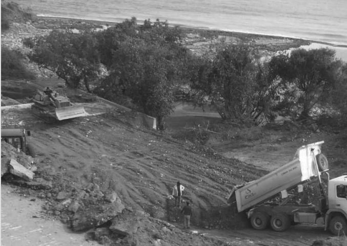
Der Durchzug von Oscar von San Antonio del Sur über die Gemeinden Imías, Baracoa und Maisi verursachte schwere Schäden an Straßen und Brücken und beeinträchtigte den Zugang zu den betroffenen Orten FOTO: JOSÉ LLAMOS CAMEJO
