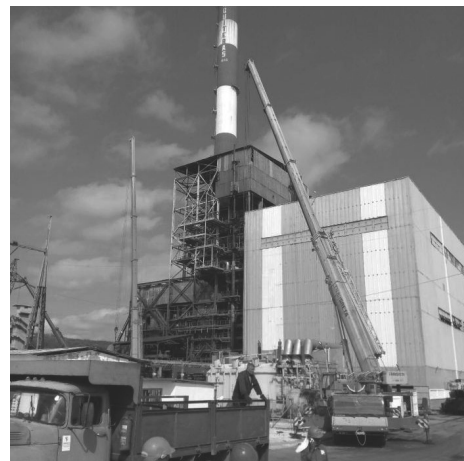
Die Arbeiten am Guiteras gehen ohne Unterbrechung weiter
