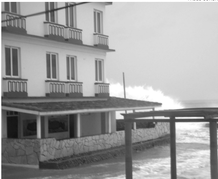
Überflutungen am Malecón von Baracoa, Guantánamo
