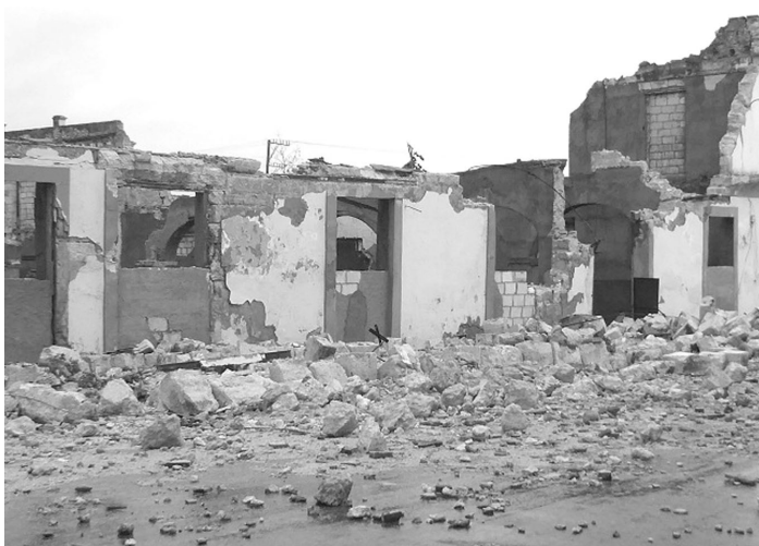
Zerstörte Häuser in Matanzas
