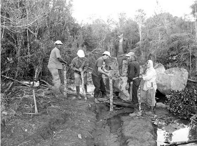
Pfähle zur Eindämmung der Auswirkungen von Wasserströmungen
