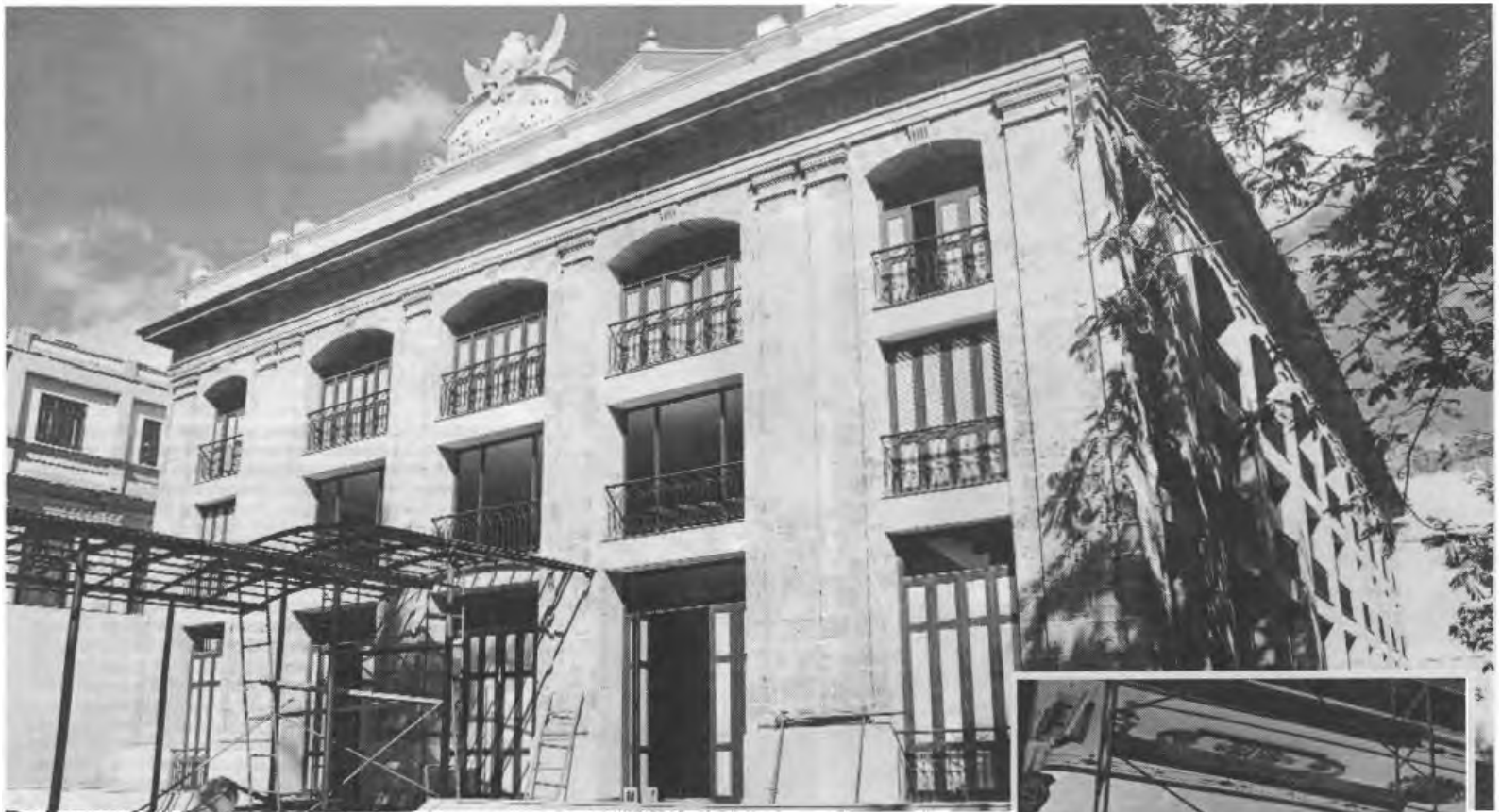
Außenansicht des Theaters Martí, das sich an der Ecke der Straßen Zulueta und Dragones befindet
