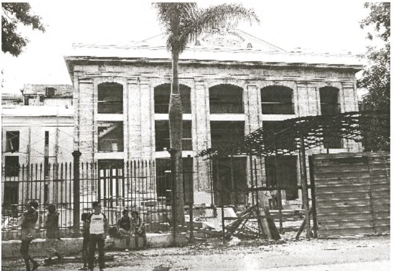
Gegenwärtig wird an der Fertigstellung des Martí-Theaters gearbeitet, einem Werk von großer Bedeutung für Havanna
