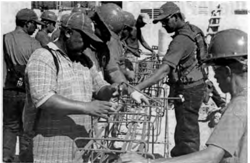
Nach einer kurzen Erklärung beherrschen alle das Befestigen der Stahlstäbe
