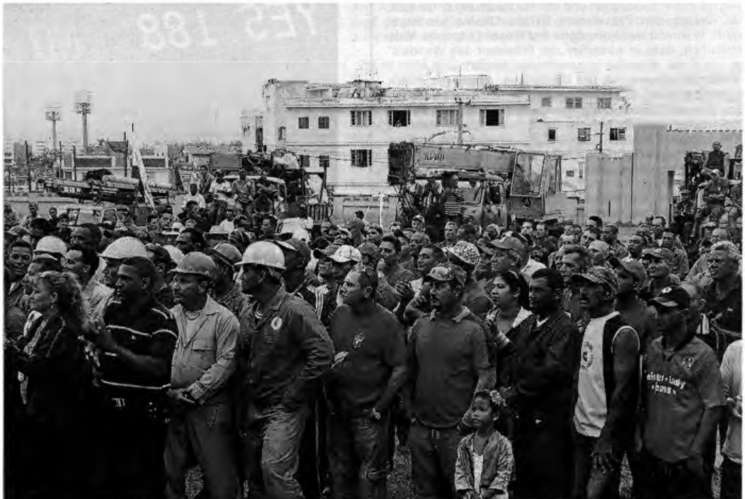
Den Elektromonteuren wurde in der Moncada-Kaserne ein herzlicher Abschied bereitet
