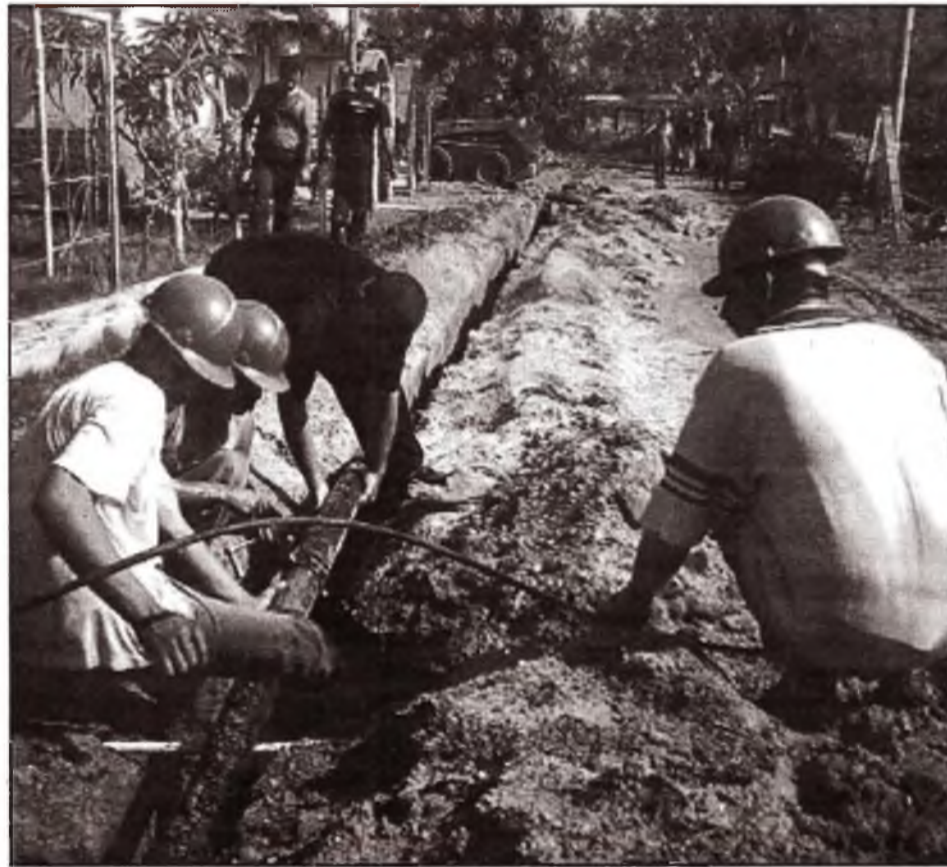
Die schlechten Reparaturarbeiten bei Rohrbrüchen stellen eines der größten Probleme dar.
